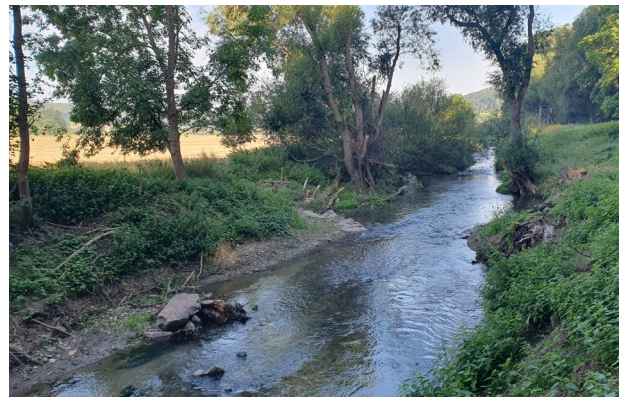
Orla im Abschnitt 10, Stützschwelle nörd. Schweinitz (ID 8657) oberhalb Kleindembach nach Umsetzung
