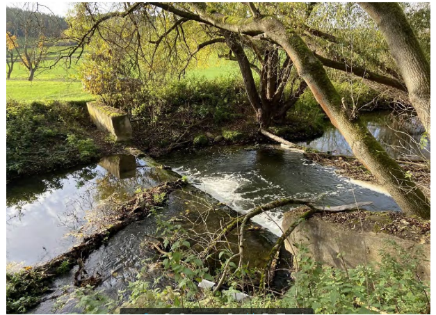
Orla im Abschnitt 10, Stützschwelle nörd. Schweinitz (ID 8657) oberhalb Kleindembach vor Umsetzung
